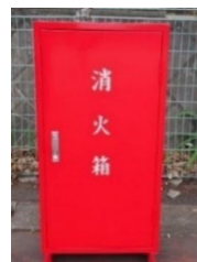
初期消火箱（固定式）
