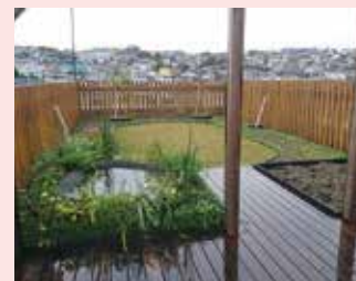
保育園の屋上園庭緑化(保土ケ谷区)
