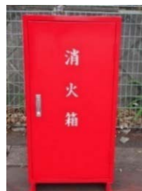
初期消火箱（固定式）
