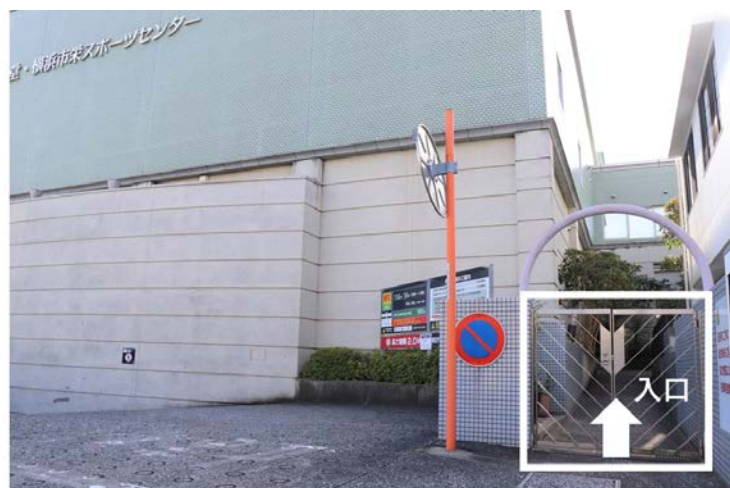
通行止め期間中の受付入口（地下駐車場入口横）
